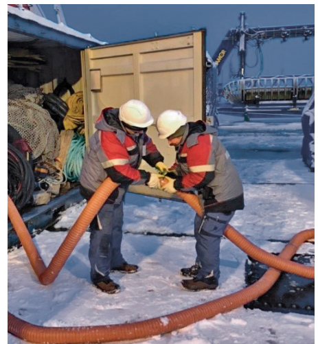
Присоединение парового рукава
